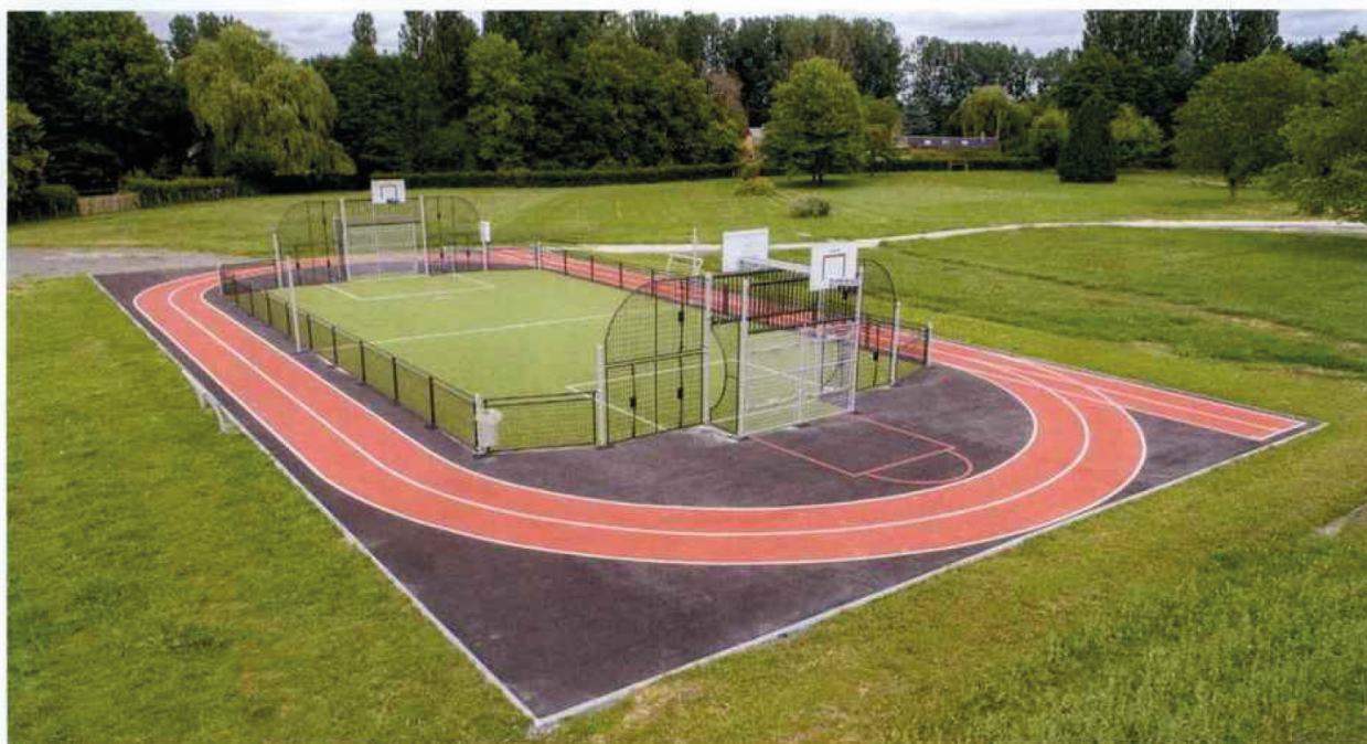
A Thorigné sur Due (72), les équipes d'Agilis ont réalisé ce multisports de la marque Transalp en scellement direct (dimension 12 m x 24 m hors tout). Le support est composé d'un géotextile et d'une grave non traitée A 0/31,5 sur 30 cm ainsi qu'une plateforme de 18 x 36 m en enrobé BB 0/6 de 5 cm, le tout en respectant une pente unique en travers de 1 %.
