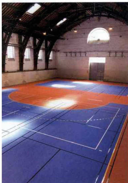
A Saumur, la salle Kellermann du gymnase USID est équipée d'un revêtement Everlay de 4,7 mm et d'un MondoFlex de 2,5 mm d'épaisseur, posé sur un enrobé (1 couche de 4 cm de BB 0/10 + 1 couche de BB 0/6). Le contrôle de la planimétrie a été effectué par le laboratoire des sols sportifs C2S.
